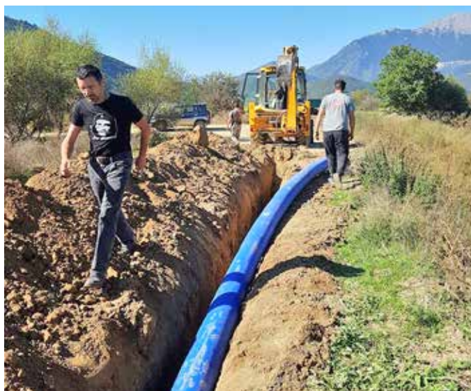
Κατασκευή αγωγού ύδρευσης από τη Στυμφαλία
