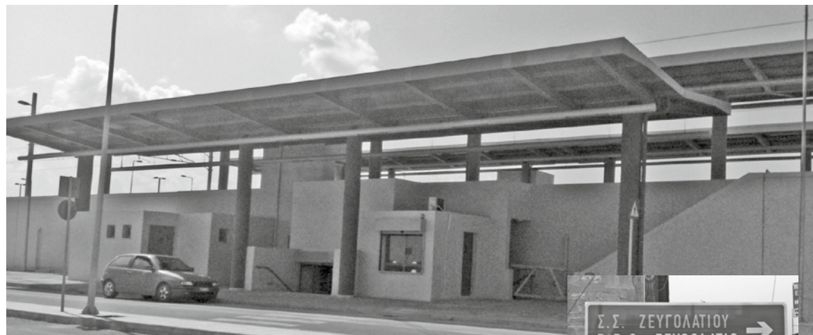
■ Ο σταθμός του Προαστιακού στο Ζευγολατιό, περιμένει έτοιμος πάνω από δύο χρόνια να ακούσει το σφύριγμα του τρένου που θα σταματήσει στις αποβάθρες του και θα επιβιβάσει ή θα αποβιβάσει κόσμο. Πάντως οι πινακίδες τοποθετήθηκαν!
