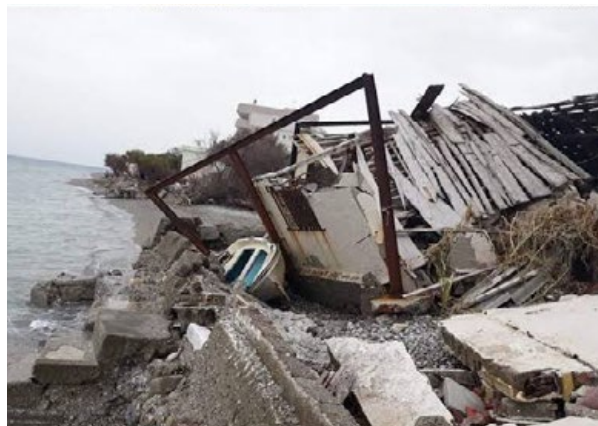
■ Το διαβρωμένο παραλιακό μέτωπο στο Ξυλόκαστρο, όπου η πολυετής ολιγωρία απαιτεί πλέον άμεσες παρεμβάσεις προστασίας.
